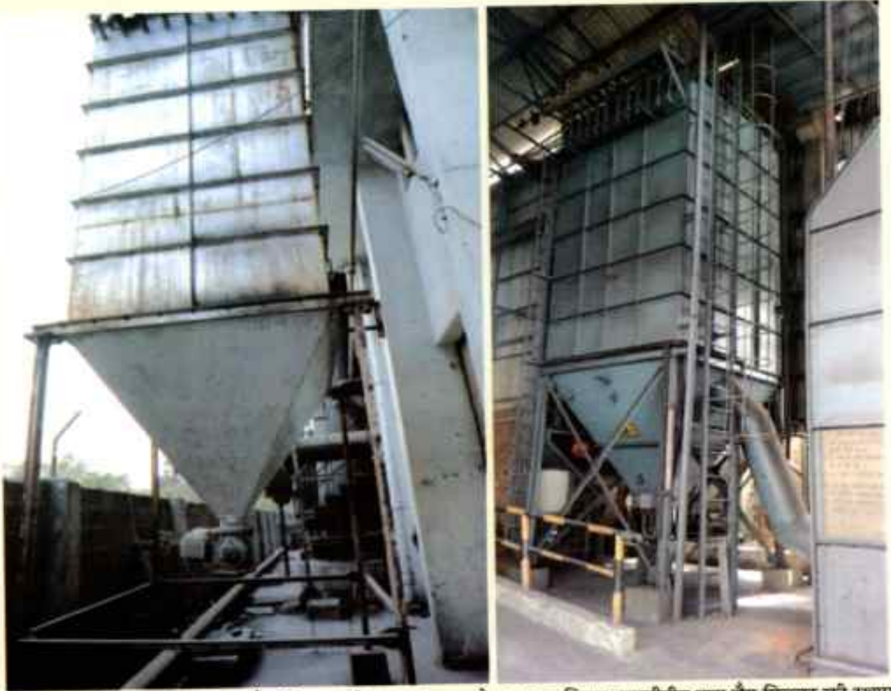
एचईजी, मण्डीदीप द्वारा बैग फिल्टर की स्थापना मेकसन न्यूट्रिशन, मण्डीदीप द्वारा बैग फिल्टर की स्थापना
